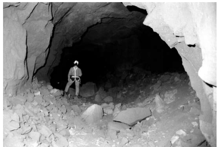
Fig. 15 - Alcuni esempi di crolli in cave ipogee di piperno (a sinistra; foto: S. Del Prete) e in tufo (a destra; foto: B. Bocchino). A seconda delle caratteristiche tecniche della roccia e del suo grado di fratturazione si possono isolare singoli massi di diversi metri cubi o numerosi massi di pezzatura notevolmente inferiore. In ogni caso l'evoluzione dei crolli porta ad una migrazione verso l'alto della volta delle cavità che, nella foto in alto a destra, è giunta alla completa asportazione del tufo e ad intercettare i depositi alluvionali a tetto del tufo stesso.
