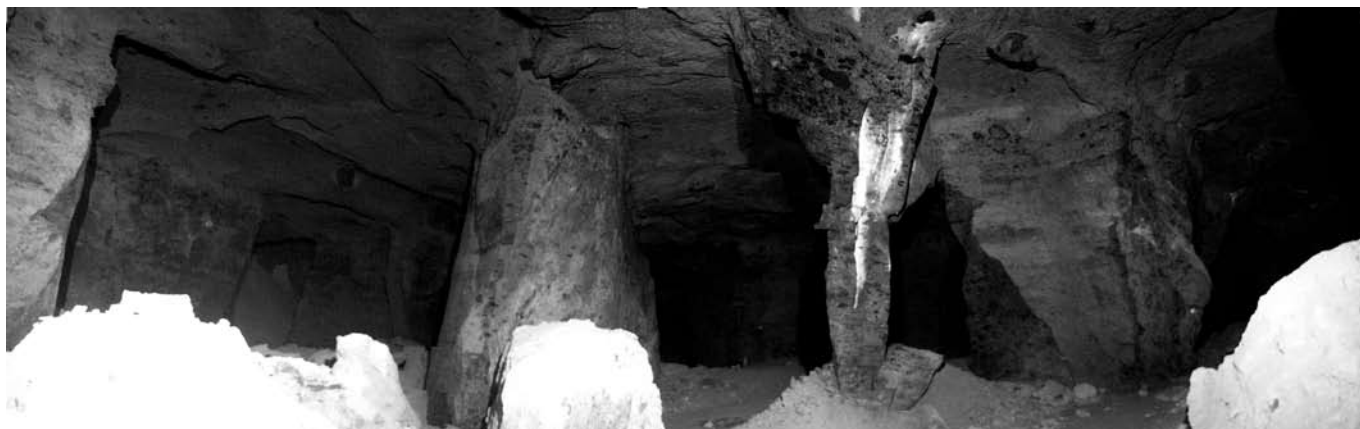
Fig. 14 - Panoramica interna di una cava di piperno (Del Prete, 2004) alla base della Collina dei Camaldoli (Napoli) in cui si notano numerosi massi staccatisi dalla volta e dalle pareti dei pilastri (foto: S. Del Prete). Questi ultimi mostrano ben evidenti gli effetti dello schiacciamento indotto dalle sollecitazioni statiche dovute ai carichi sovrastanti.
