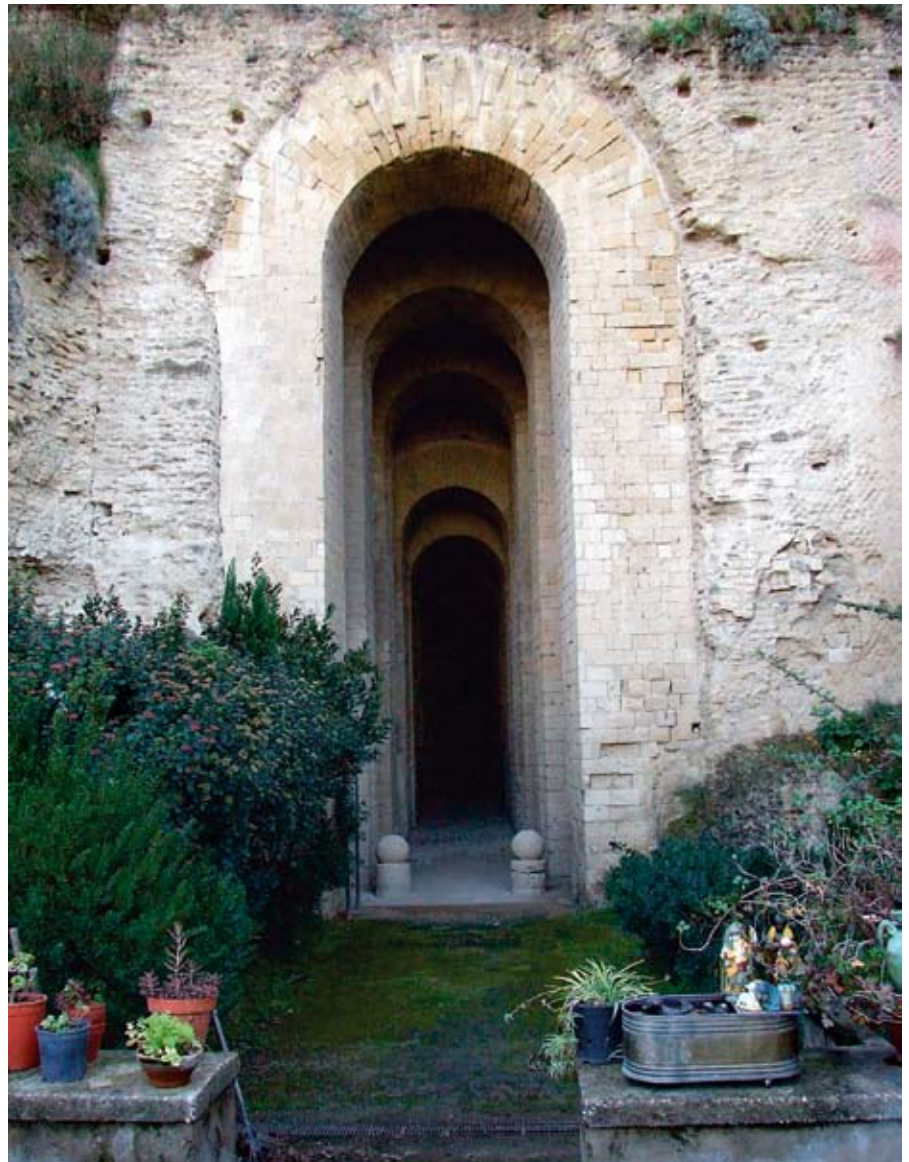
Fig. 2 - Ingresso della Grotta di Seiano tra Napoli e Pozzuoli. La larghezza della sezione non supera i 2 metri (foto: N. Damiano).
