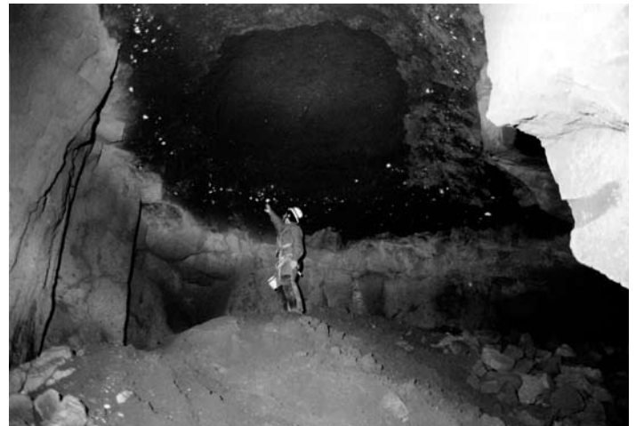
Fig. 16 - Ani, Turchia orientale. Assottigliamento di pilastri in una miniera di ossidiana (foto: R. Bixio - Centro Studi Sotterranei). La tipica scheggiatura che si genera lungo le pareti dei pilastri è causata dai carichi verticali esercitati dal peso delle rocce sovrastanti.
