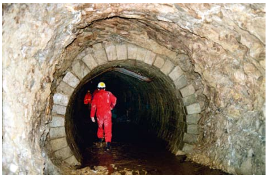
Fig. 4 - Miniere di cinabro della valle del Siele (Toscana). Passaggio litologico tra rocce litoidi dotate di buone caratteristiche di autosostegno (calcari marnosi in primo piano privi del rivestimento) e argilloscisti fortemente spingenti (sullo sfondo), che invece necessitano della realizzazione di rivestimenti delle pareti per mantenere accessibile la galleria mineraria (foto: S. Del Prete).
