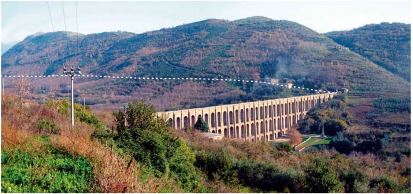
Fig. 1 - Panoramica della struttura ad archi dei Ponti della Valle e del colle di Longano lungo i cui fianchi si sviluppa il tracciato ipogeo (evidenziato dal tratteggio) dell'acquedotto Carolino (foto: S. Del Prete).
