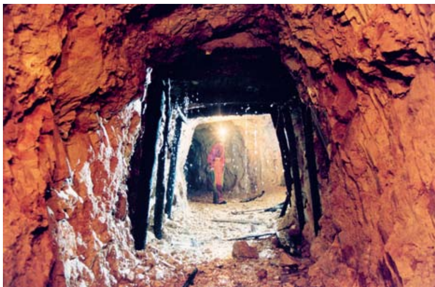
Fig. 5 - Quadrine di sostegno della volta nelle miniere di bauxite di Cusano Mutri (Monti del Matese - Campania) realizzate in corrispondenza di una frattura carsificata intercettata dallo scavo (foto: B. Bocchino). È evidente lo stillicidio associato al drenaggio preferenziale delle acque di infiltrazione attraverso la frattura stessa.
