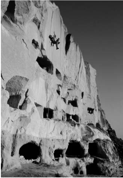
Fig. 11 (sopra) - I fenomeni da crollo che hanno interessato la falesia tufacea hanno portato a giorno i vani sotterranei scavati nel versante (foto: G. Bologna).
