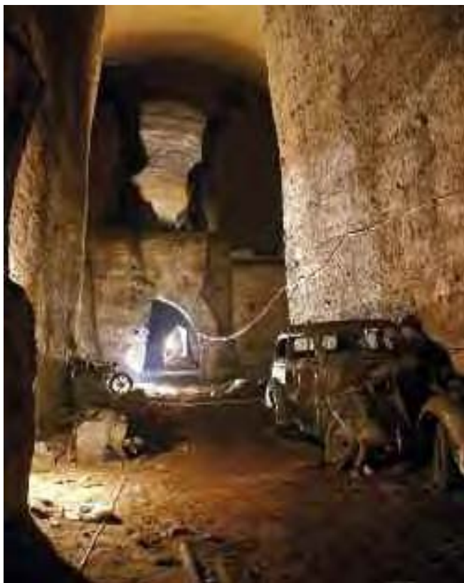
Figura 6 – Il tunnel borbonico di Via Morelli a Napoli (foto G. Minin).
