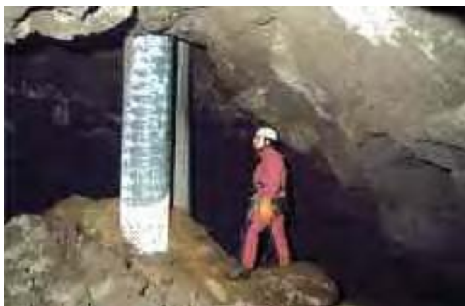
Figura 9 – Cava di tufo a Gragnano attraversata da un pilastro di fondazione di un edificio soprastante (foto B. Bocchino).
