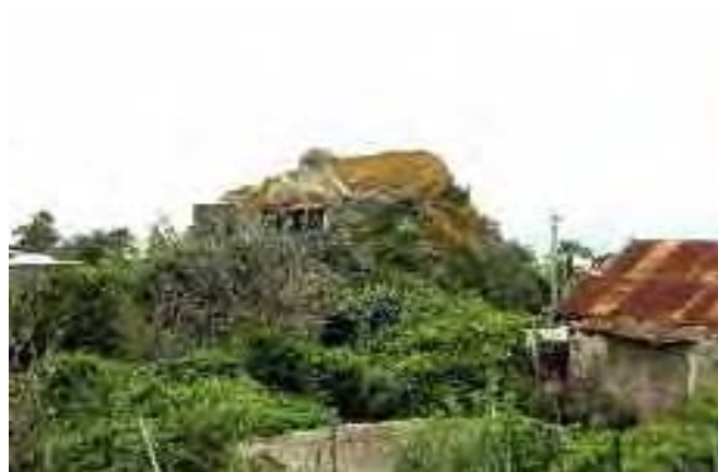
Figura 5 – Tipica "casa di pietra" ricavata in un masso di Tufo Verde sull'isola d'Ischia. La "naturalità" del manufatto che rimane perfettamente inserito nel suo contesto geologico e geomorfologico, forniva a questi insediamenti una importante funzione di mimetismo difensivo (foto L. Di Iorio).
