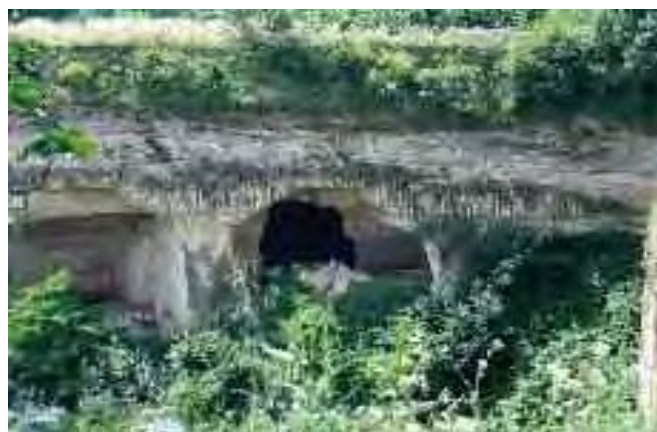
Figura 10 – Antica cava di tufo ipogea intercettata dalla più recente cava a cielo aperto (loc. Risigliano, comune di Tufino; foto S. Del Prete).
